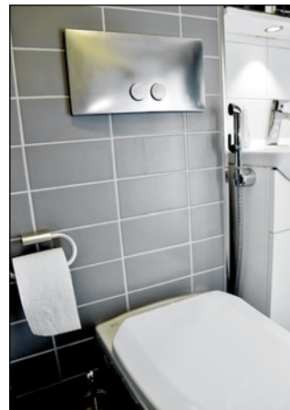
WC-laite on huollettavissa avattavan painikepaneelin kautta. Painikkeen värit: valkoinen, kromi ja mattakromi.
