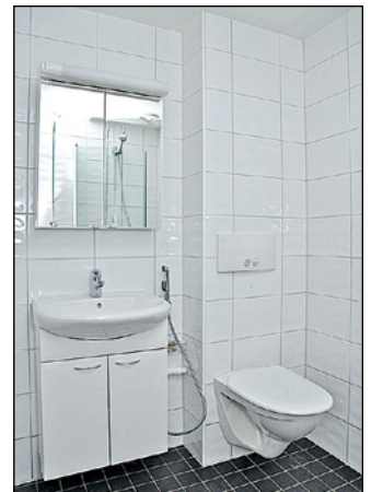
Asor-elementti E631 laatoitettu- na ja kylpyhuone kalustettuna. Pesualtaan sekoittaja ja viemäri kytketty elementtiin.
